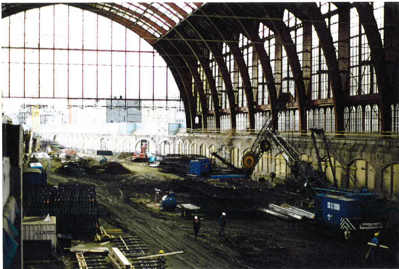
Zo zag op 25 januari 2002 de bouwwerf er uit. Er kan nu gestart worden met de constructie van de perrons kant Pelikaanstraat. Foto : Luc Couscheir.
